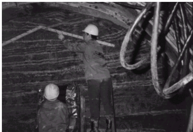
Рис.6. Рабочий момент зондирования «лба» забоя георадаром «ТР-ГЕО» (вып.1998 г.)
